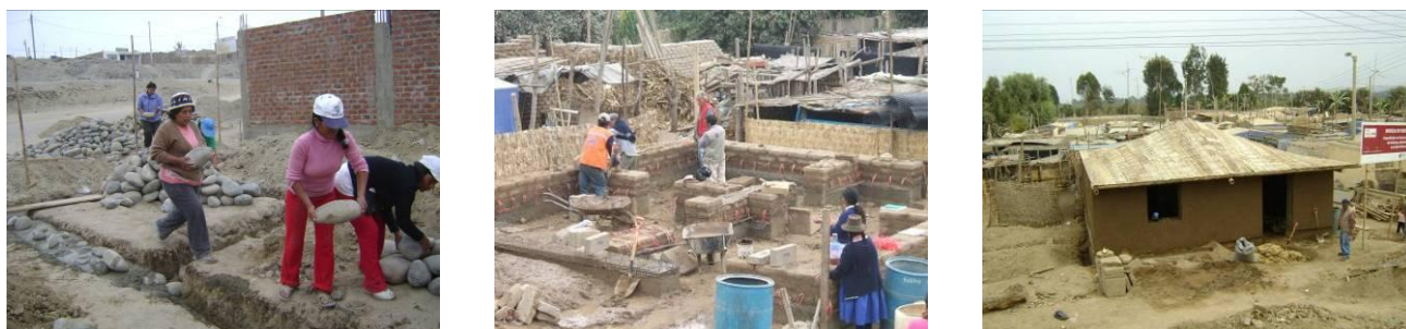
Figura 8. Construcción de casas de adobe reforzado
