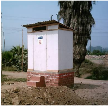
Figura 3. Letrina de hoyo seco ventilado
